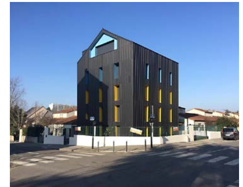
Bâtiment de NMH, futur Centre de Santé Photographie Nantes Métropole
