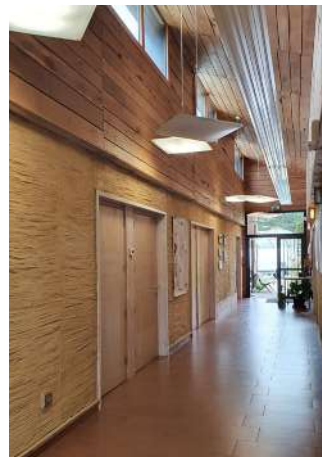
Parois de roseaux enduits terre, Pôle SEVE Bouguenais
