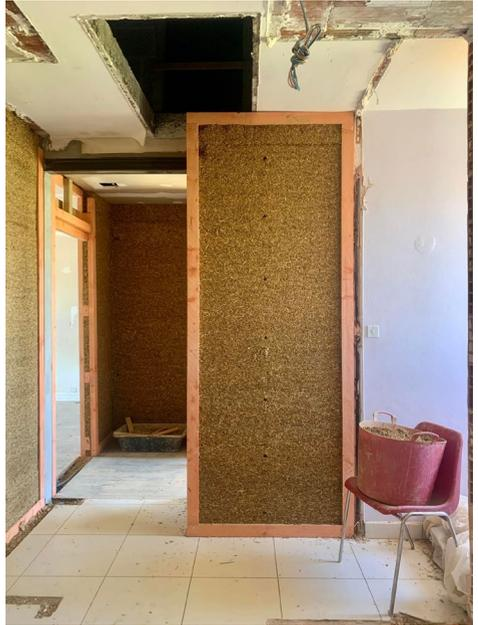
Cloisons séparatives des chambres réalisées en terre crue (terre allégée et enduit terre)
