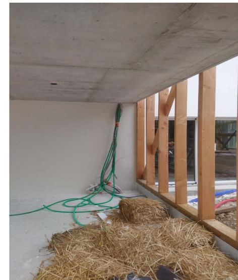
Remplissage du mur en ossature bois avec la paille
