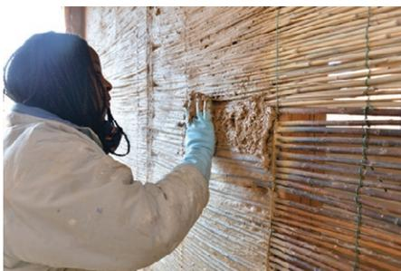
7 - Une fois le débranchage effectué, on renforce la terre à l'aide d'une brosse à tapisser afin de d'obtenir un support plus lisse sur lequel un enduit de finition plus fin est posé au gant.
