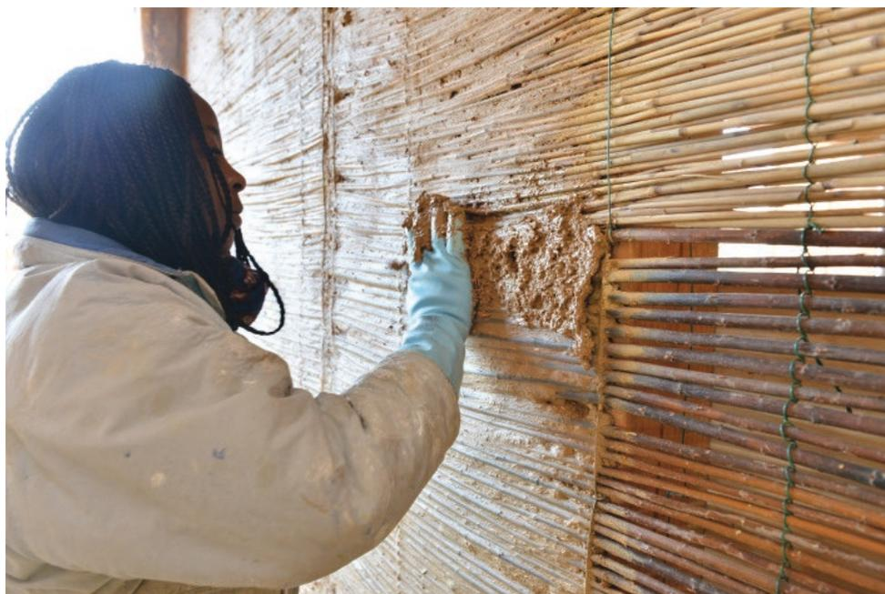
*Pose de l'enduit terre sur une structure en roseau*
