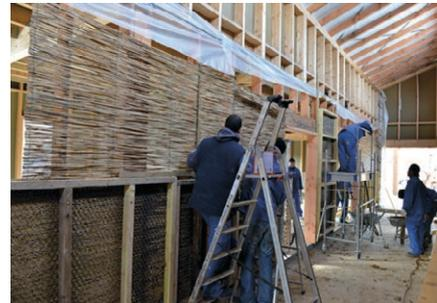
4 - Les armatures de roseaux sont posées, clouées et raboutées sur l'ossature bois pour une belle qualité de finition.
