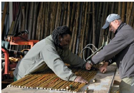
2 - Une fois séchés, les roseaux sont assemblés pour former l'armature des murs.
