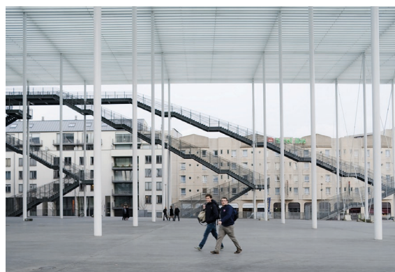
Theaterplein _ Bernardo Secchi + Paola Viganò
