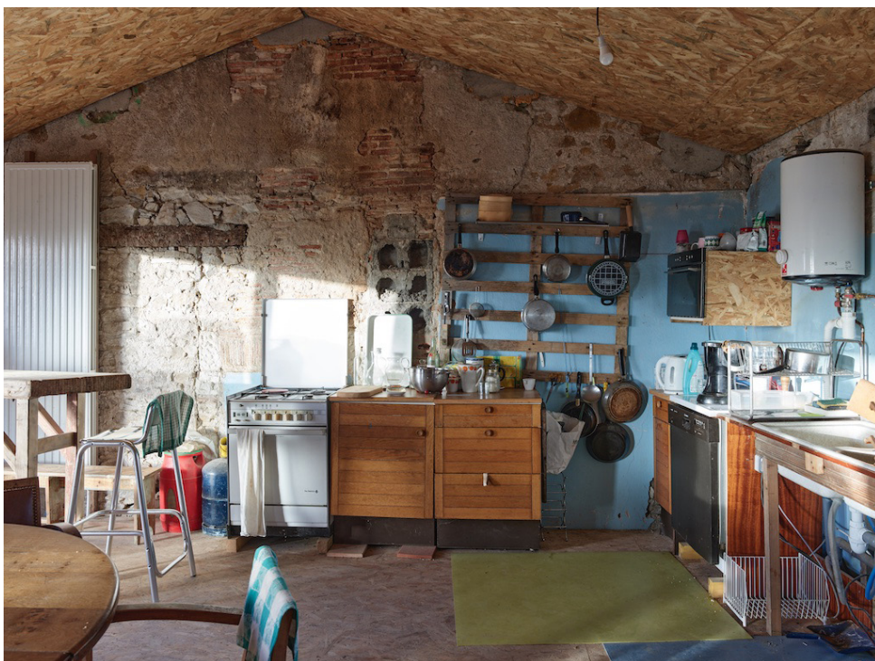
La salle commune en chantier. Photo ©Stéphane Chalmeau
