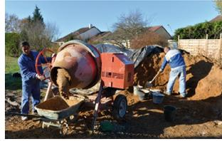
1 - Les roseaux sont coupés en bord de Loire et la terre est directement extraite du terrain pour servir de base au remplissage composé de terre + chanvre + chaux + eau.
