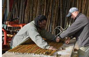
2 - Une fois séchés, les roseaux sont assemblés pour former l'armature des murs.
