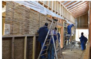
4 - Les armatures de roseaux sont posées, clouées et raboutées sur l'ossature bois pour une belle qualité de finition.
