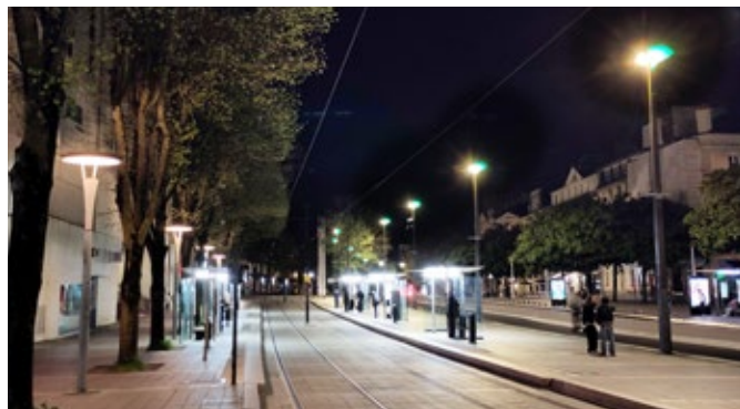
→ Photo : Cours des 50 Otages, candélabres « promenade » à chapeau réflecteur (5,60m de haut) et candélabres « voirie » à corolle lumineuse (9,50m de haut) - photo ardepa
