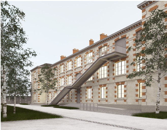
Vue de la façade nord sur le nouvel escalier de secours
