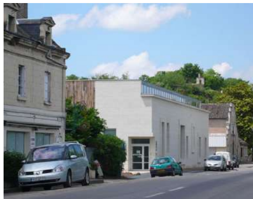
Vue sur façade Est, entrée principale
