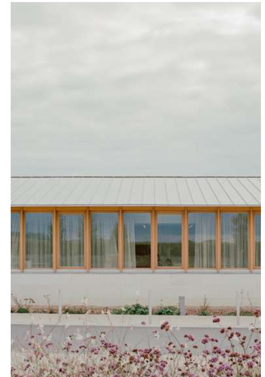
La pierre calcaire souligne le sous-bassement du bâtiment
