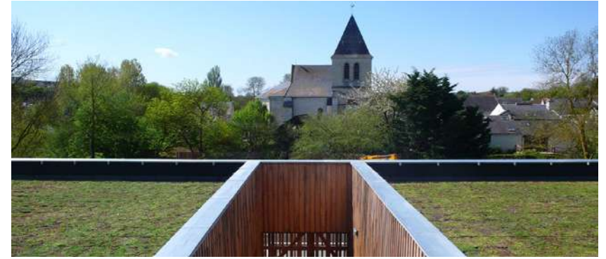
Vue sur le patio, l'église de Montsoreau et la toiture végétalisée
