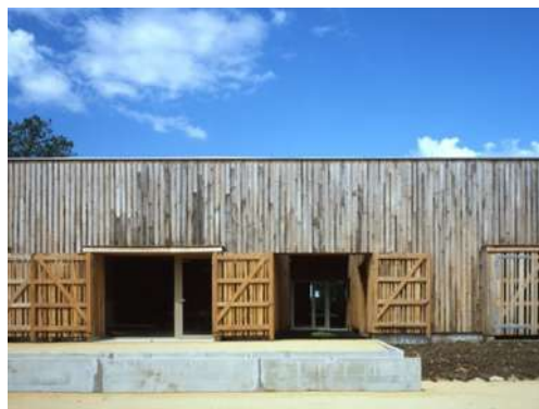
Vue sur façade Sud
